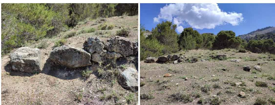
Fotografía 15: Restos de estructuras murarias en el cierre sur del recinto.
