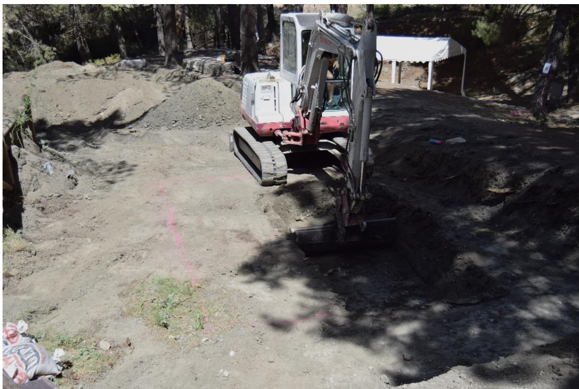
Fotografía 36: Apertura del sondeo 011 mediante maquinaria pesada.
