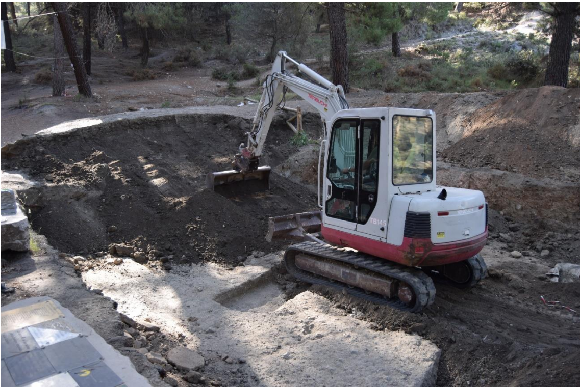
Fotografía 50: Tareas de tapado de los Sondeos 008, 011 y 012 en la Zona 2.
