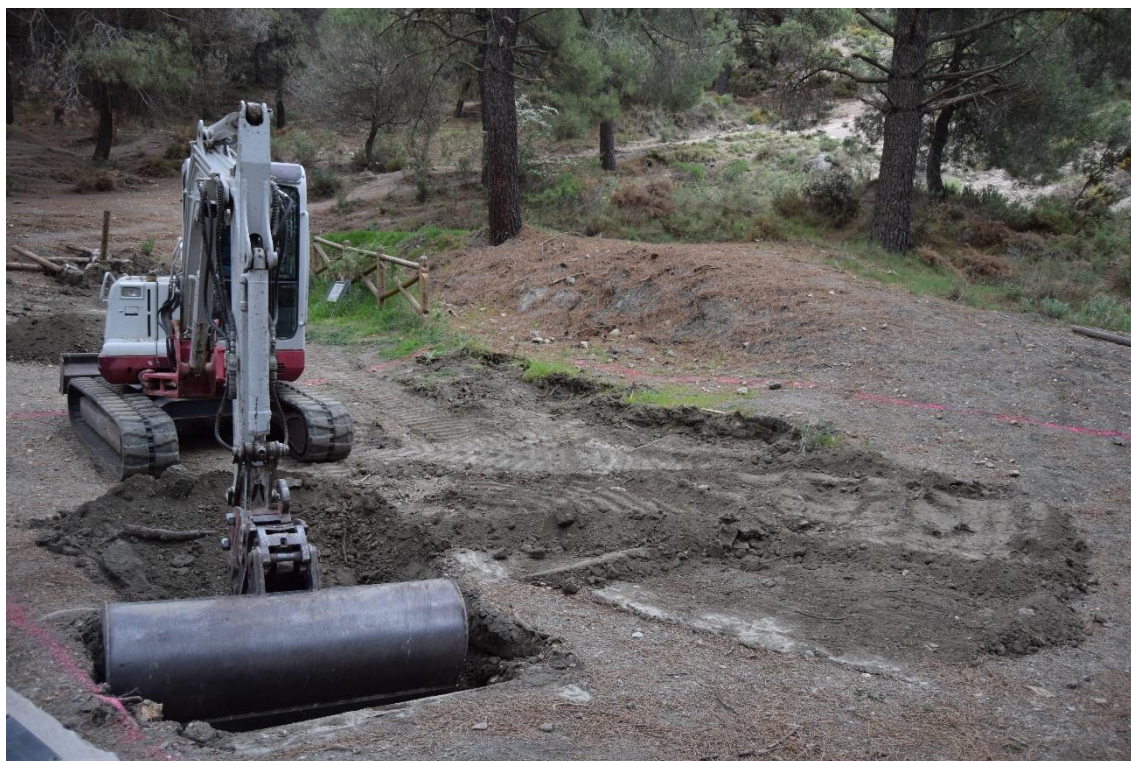
Fotografía 20: Apertura del Sondeo 008 mediante máquina.
