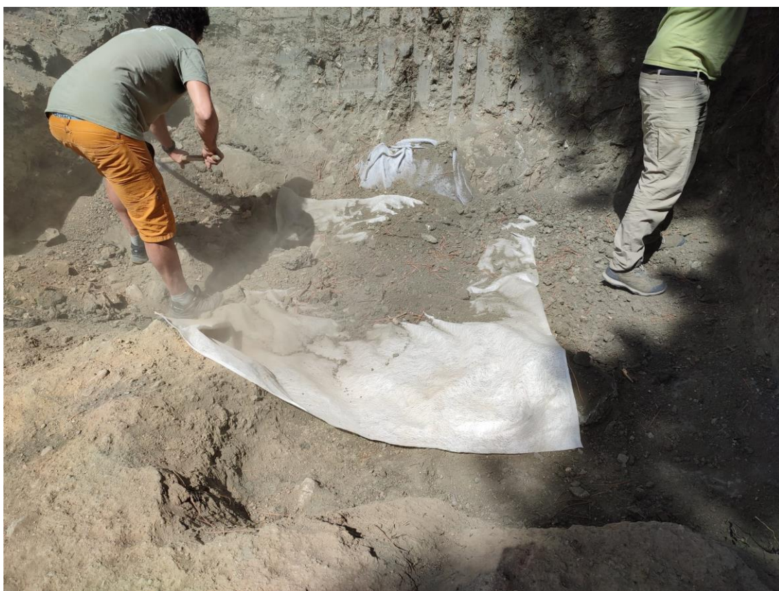
Fotografía 45: Colocación del geotextil y tapado con tierra cribada sobre el CE 016.
