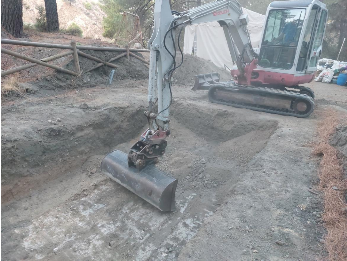
Fotografía 39: Rebaje con máquina retroexcavadora en la parte este del sondeo 11.
