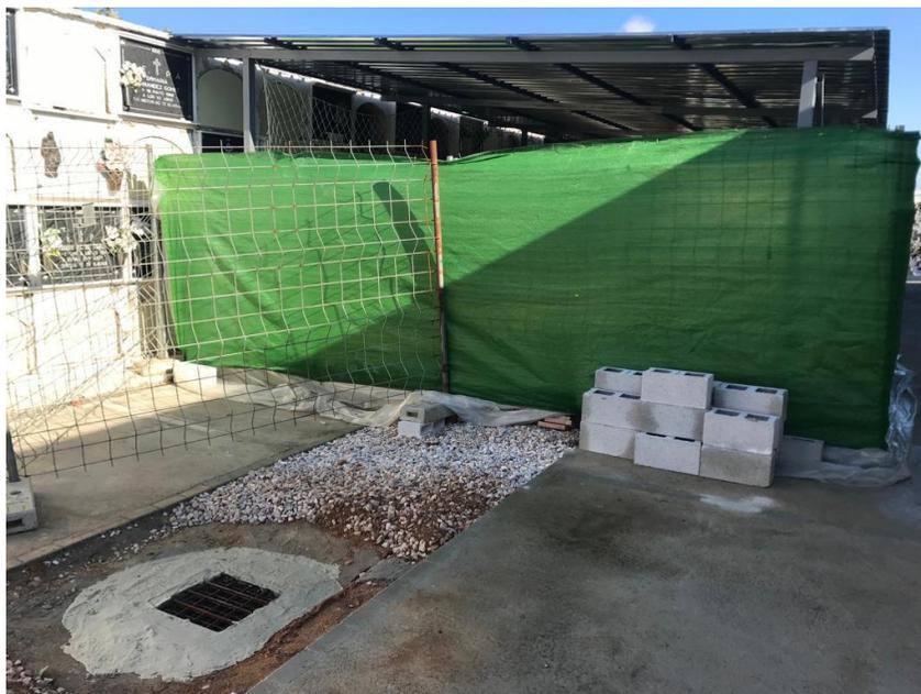
Imbornal de nueva construcción para contener las aguas pluviales.
