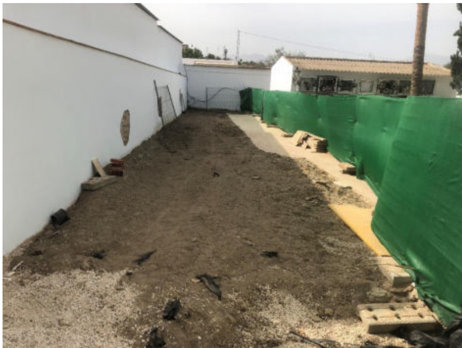
lamina 50 Cubrición de la zona intervenida con la tierra extraída
