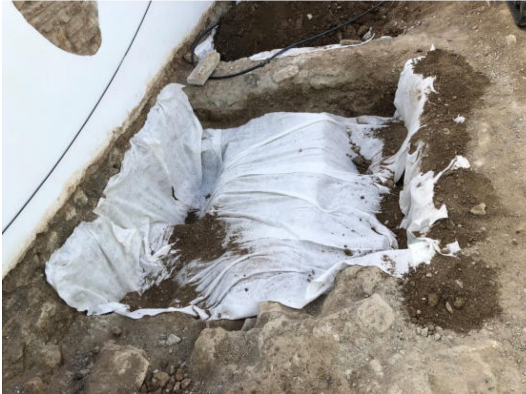
lamina 49 Detalle de geotextil colocado en la fosa 5
