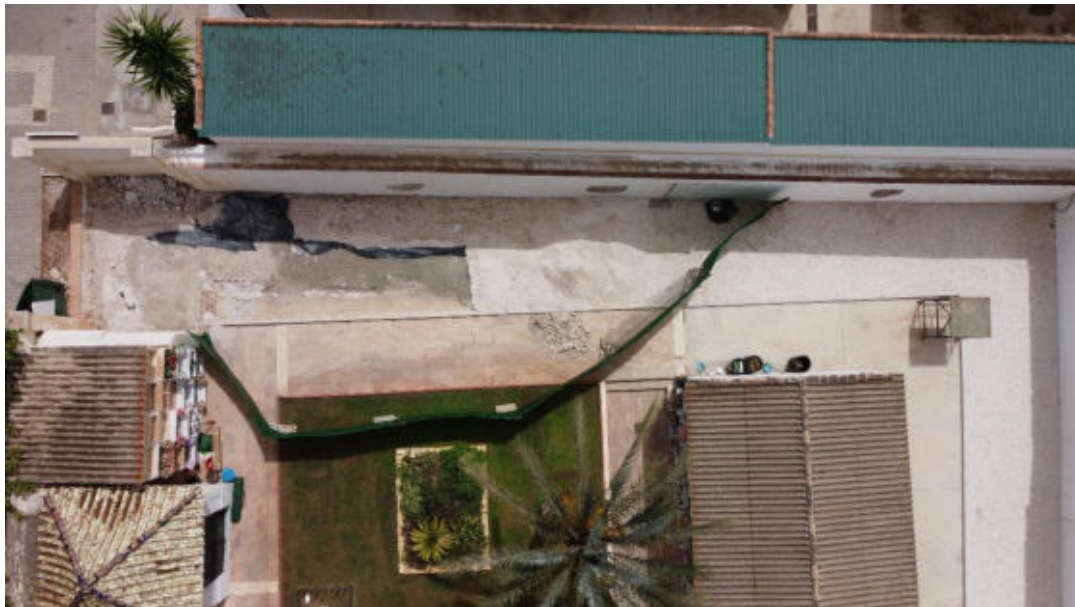
lamina 51 Ortofoto de la zona intervenida
