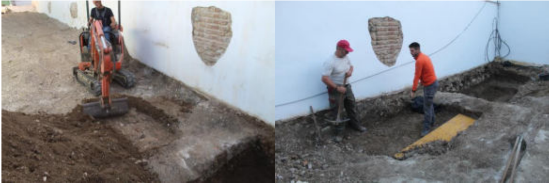
lamina 58 Trabajos de localización en el patio civil
