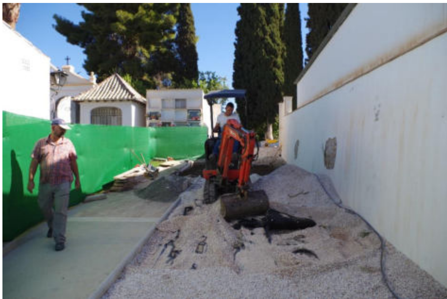
lamina 55 Trabajos en el segundo sector
