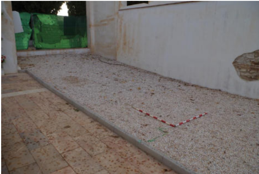
lamina 1 Zona de actuación en el inicio de los trabajos
