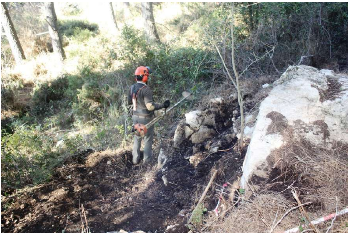
Labores de desbroce y limpieza de la zona de intervención.
