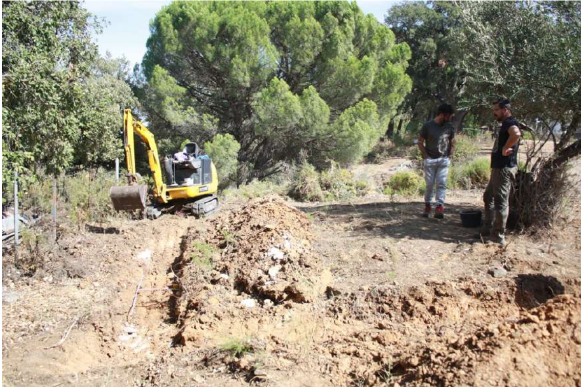
Sondeo 6. Vista desde el SO.
