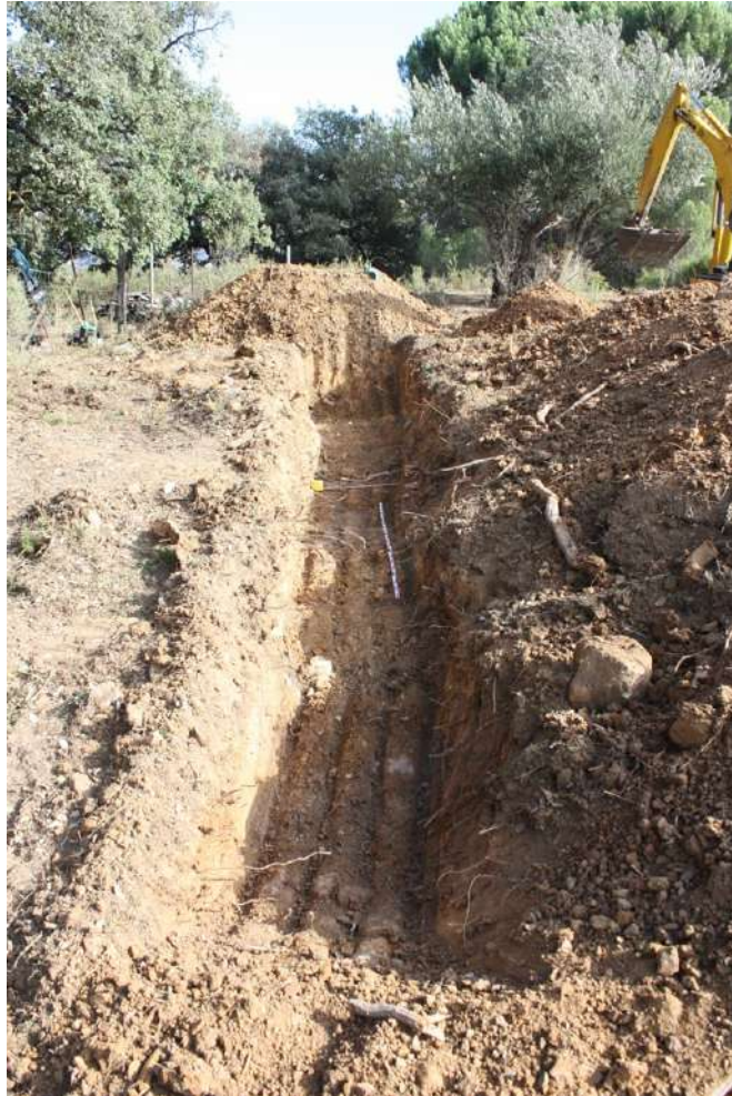
Sondeo 2. Vista desde el SO.
