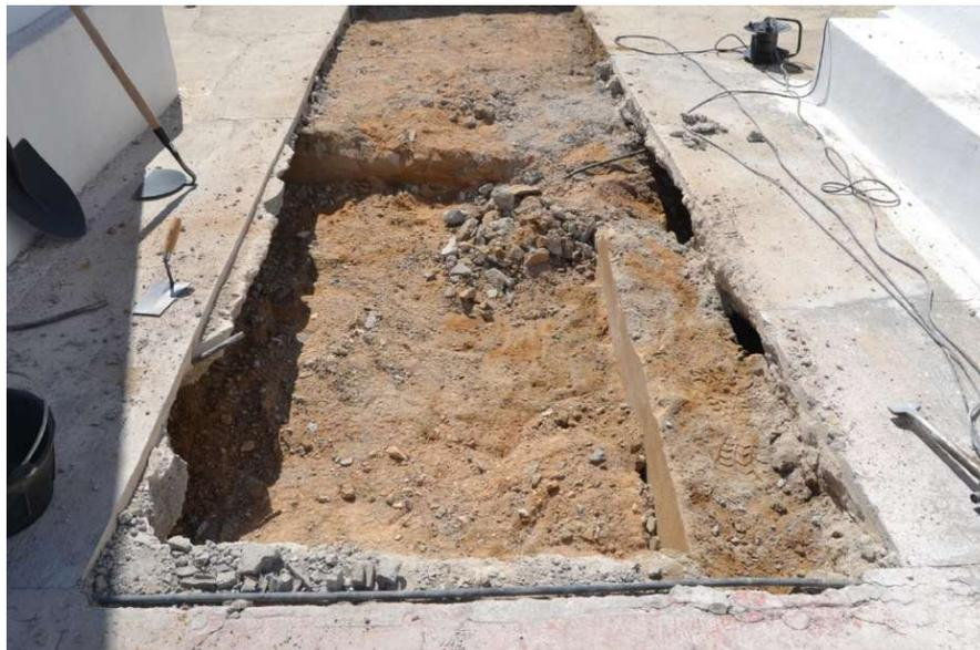
Figura 39. Corte 1 tras la retirada de la capa de hormigón.
