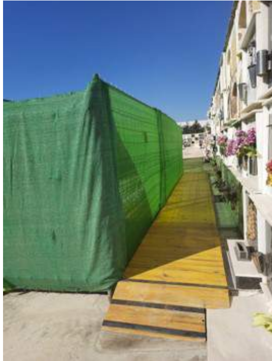
Figura 4.49.- Ejecución de pasillo para acceso a cuerpos de nichos contiguos a la fosa.
