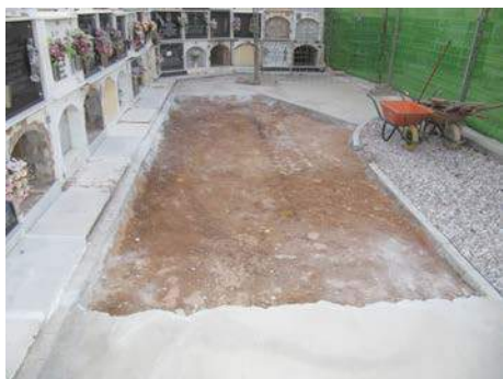
Figura 4.29.- Retirada de solera de hormigón y proyección del sondeo 1.
