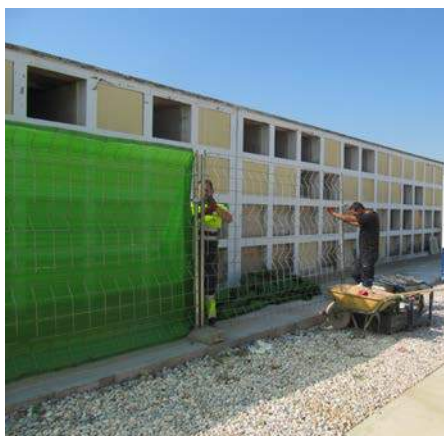
Figura 4.28.- Instalación de vallado perimetral en uno de los sectores intervenidos. (Sondeo 1).
