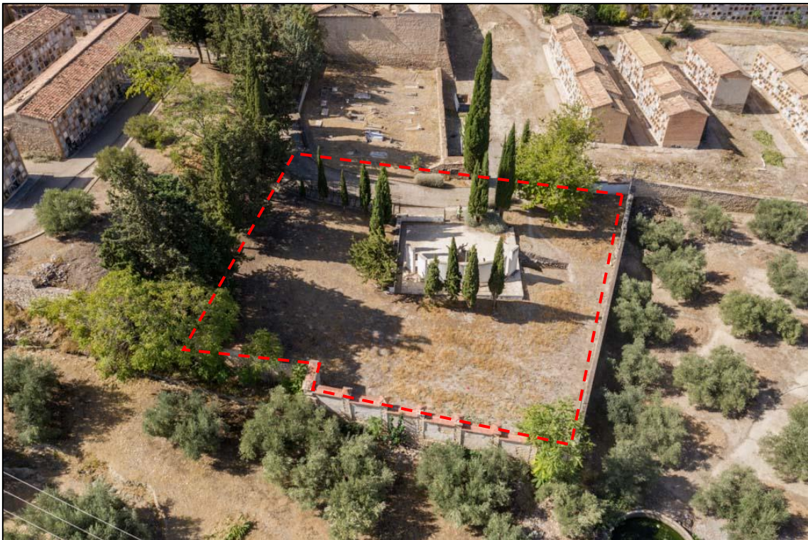
Fig. 5. Área de actuación: Corralito de los ahorcados vista desde el este.
