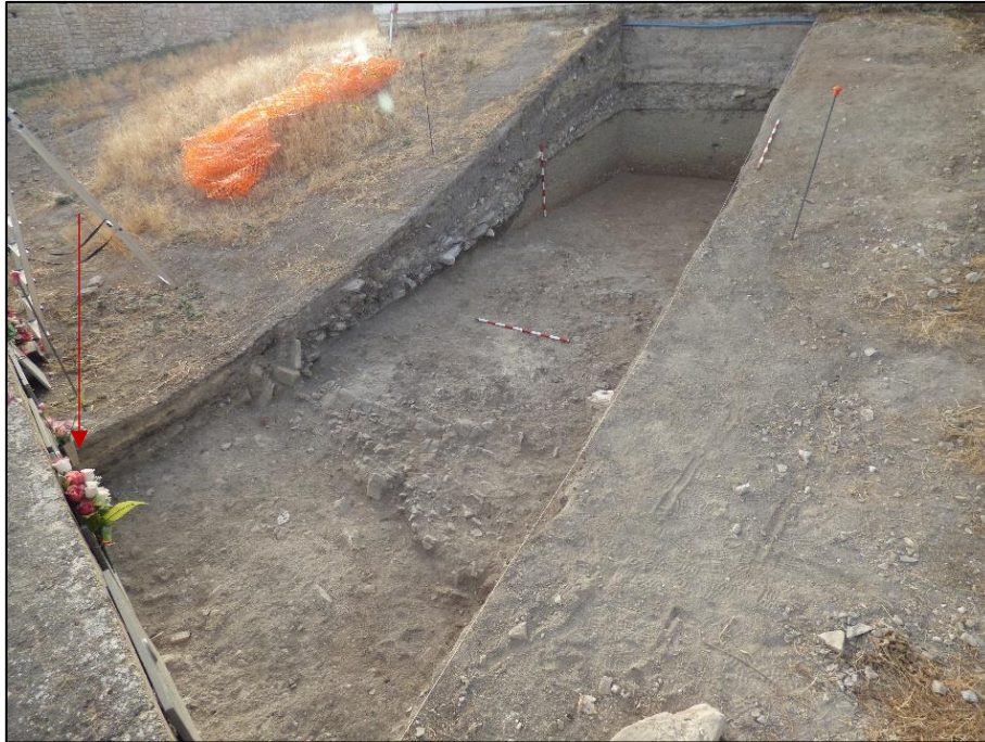
Fig. 17. Corte 1. Detalle de la zanja de cimentación del muro de hormigón.
