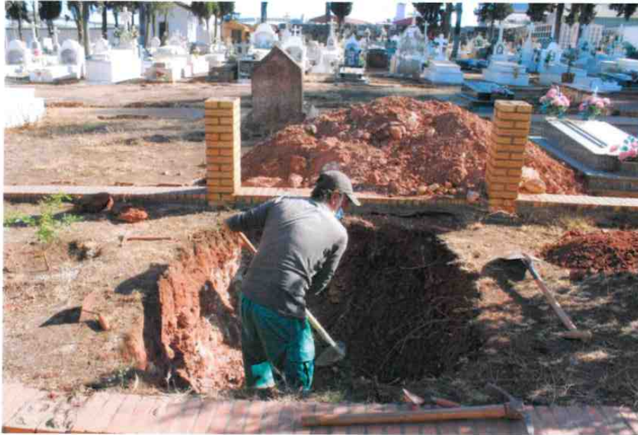
Foto. Detalle del rebaje manual en el sondeo 3.
