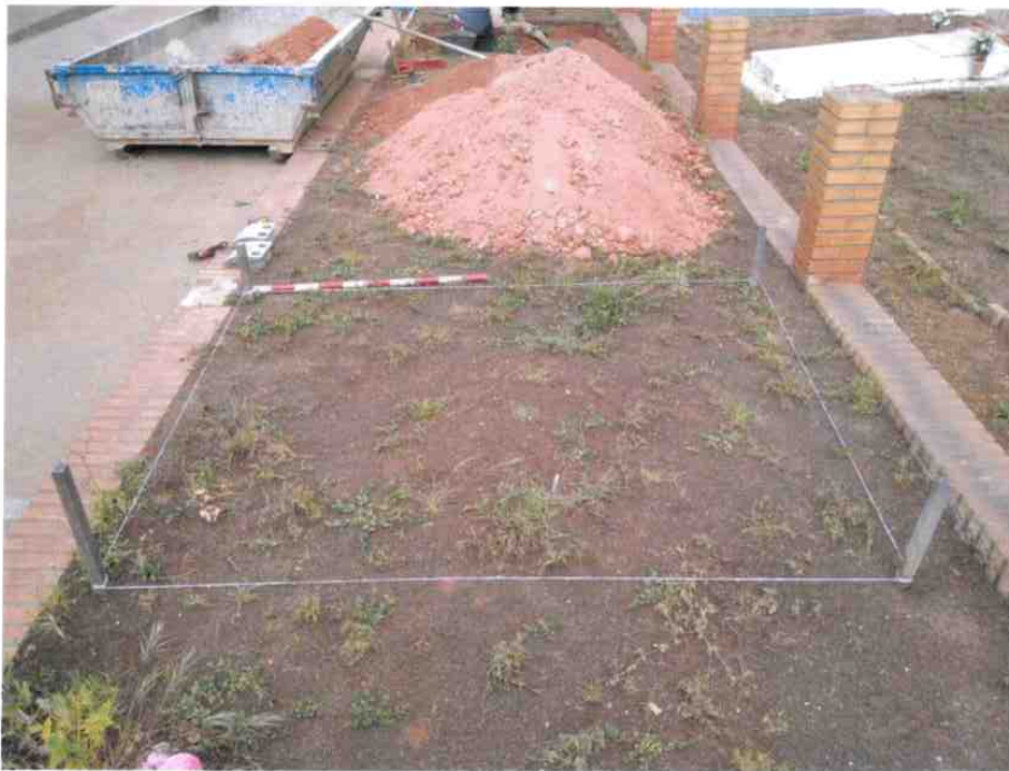
Foto. Inicio del sondeo 2.
