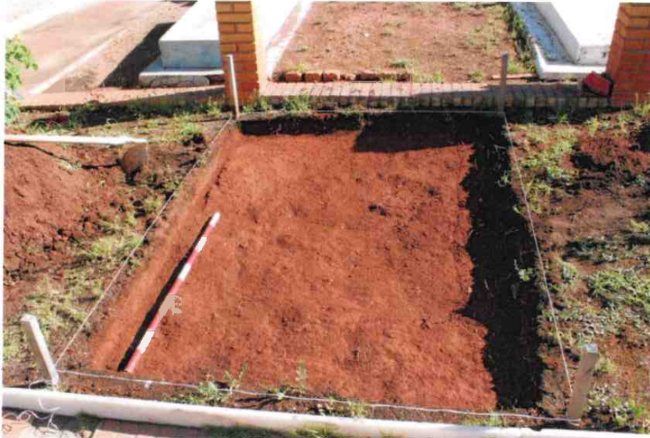
Foto. Sondeo 1, tras la retirada tierra vegetal.
