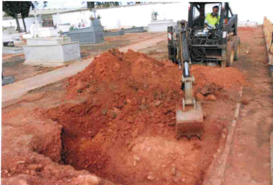
Foto. Detalle de retirada del primer sedimento con medios mecánicos.
