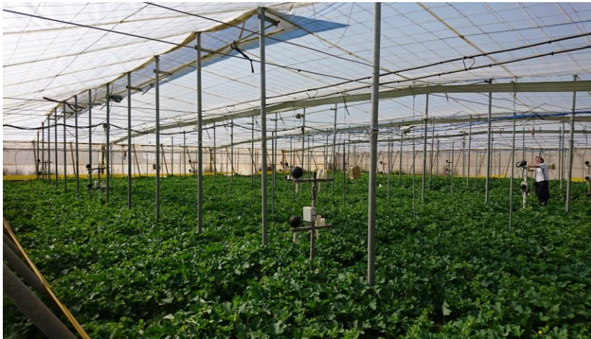
Figura 84. Instalación completa de sistema de medida en invernadero (XI).
