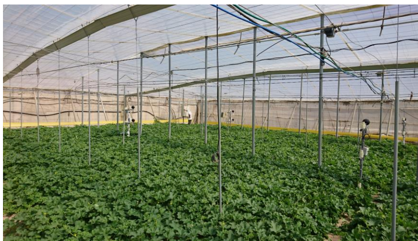
Figura 78. Instalación completa de sistema de medida en invernadero (V).
