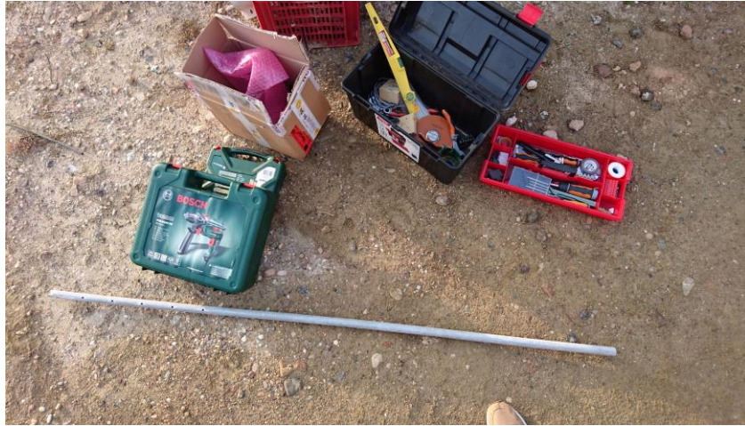
Figura 115. Instalación completa de sistema de medida en invernadero. Montaje sensor UVI exterior (I).
