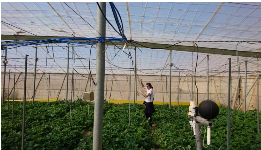
Figura 82. Instalación completa de sistema de medida en invernadero (IX).
