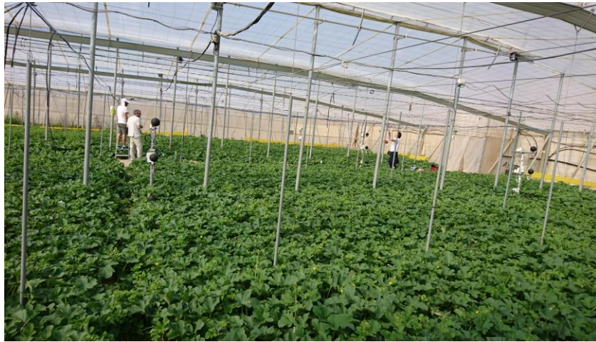
Figura 92. Instalación completa de sistema de medida en invernadero (XIX).
