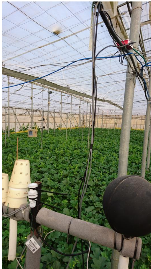
Figura 114. Instalación completa de sistema de medida en invernadero (XLI).
