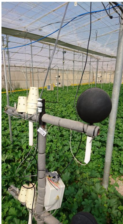
Figura 106. Instalación completa de sistema de medida en invernadero (XXXIII).
