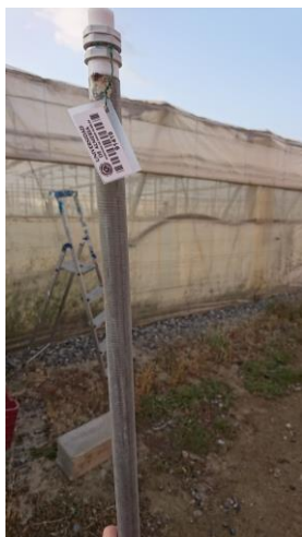
Figura 118. Instalación completa de sistema de medida en invernadero. Montaje sensor UVI exterior (IV).
