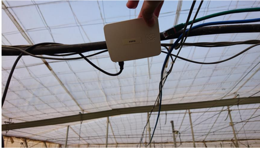
Figura 107. Instalación completa de sistema de medida en invernadero (XXXIV).
