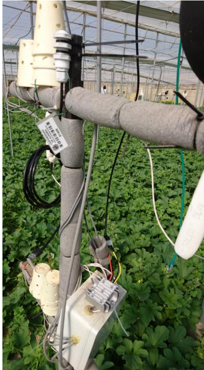
Figura 105. Instalación completa de sistema de medida en invernadero (XXXII).
