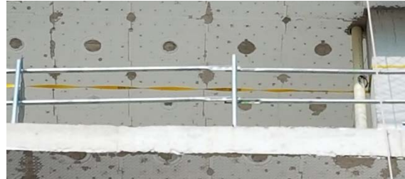
Línea de vida horizontal textil para la colocación de la red vertical perimetral del edificio.
