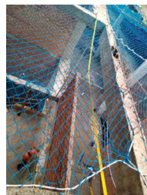
Línea de vida horizontal textil utilizándose para la ejecución de la fábrica de albañilería.
