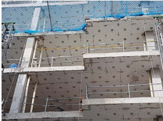
Línea de vida horizontal textil para la colocación de la red vertical perimetral del edificio.
