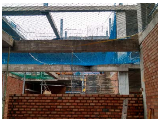
Línea de vida horizontal textil utilizándose para la ejecución de la fábrica de albañilería.
