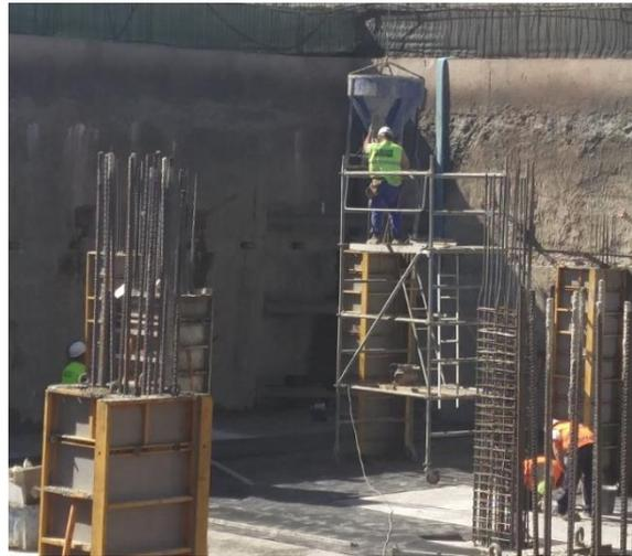
Figura 16. Hormigonado de pilar con cubilete
