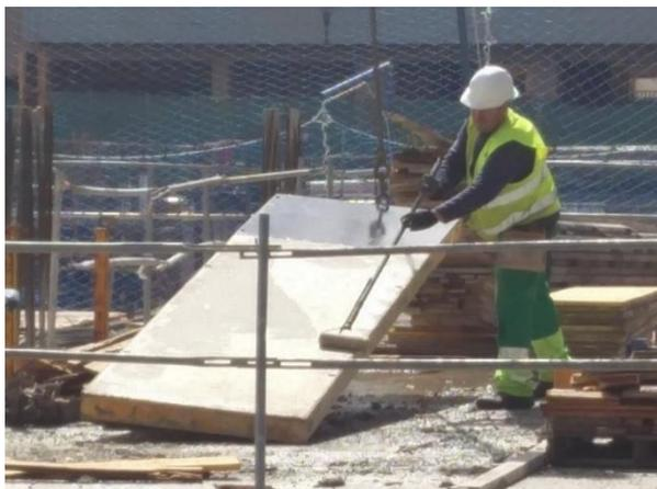
Figura 15. Aplicación de desencofrante a los paneles de encofrado de pilares
