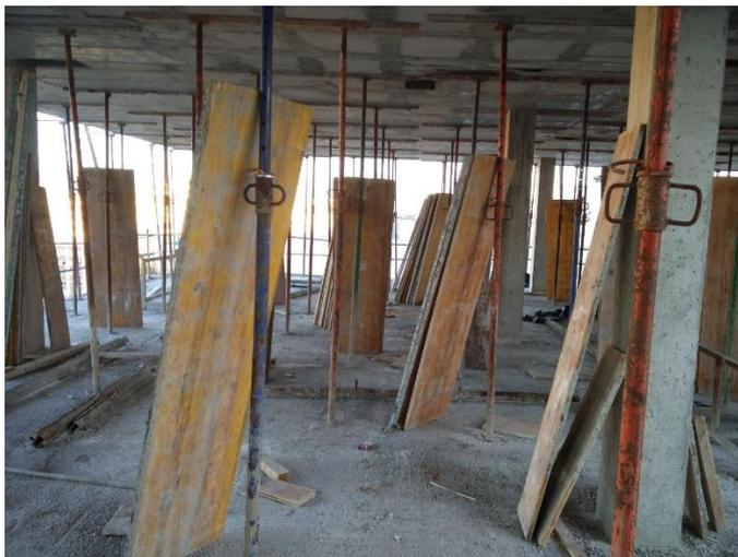
Figura 19. Desencofrado parcial de la planta
