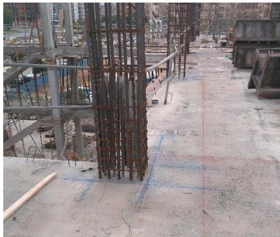
Figura 14. Replanteo de pilar con azulete
