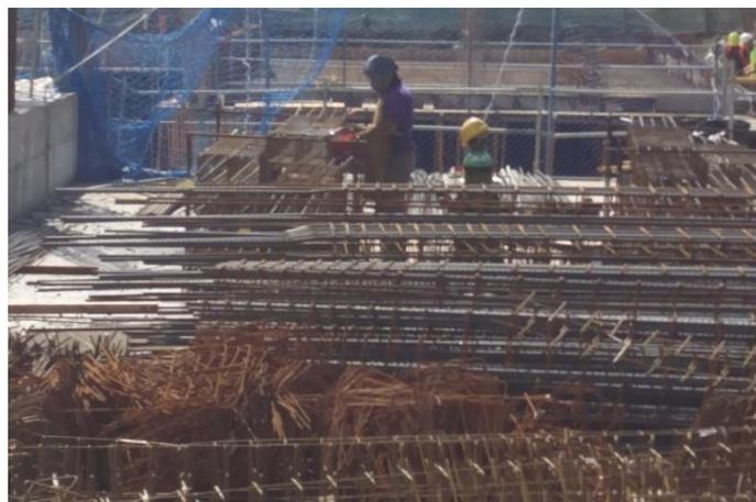
Figura 18. Elaboración de elementos estructurales de ferralla in situ
