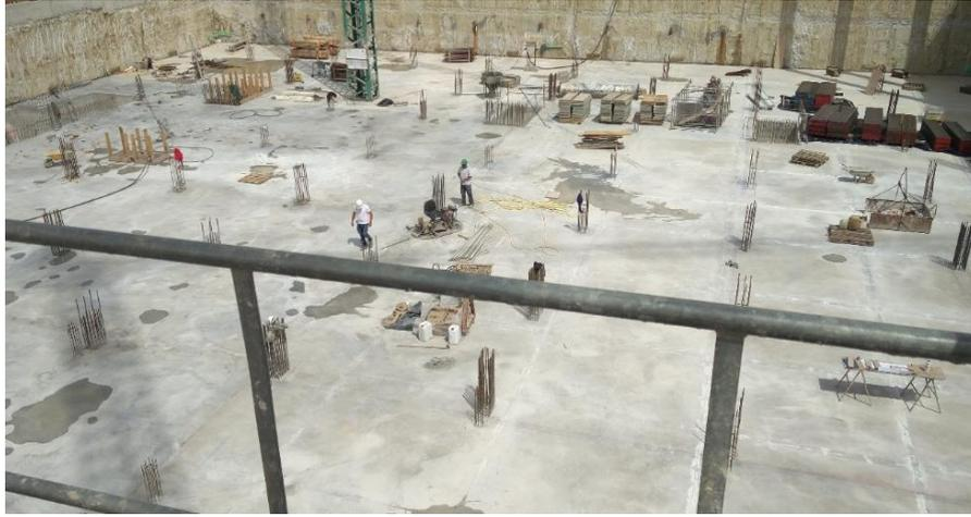
Figura 13. Armaduras de arranque sobre losa de cimentación
