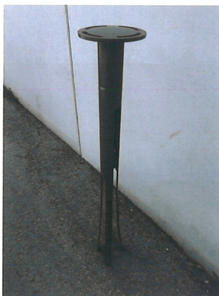
Figura 389. Cajetín de anclaje diseñado para su instalación en la cabeza de los tubos de los pies derechos
