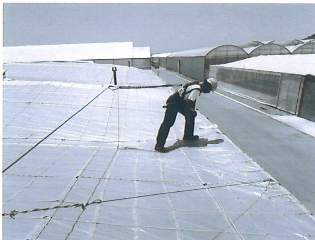
Figura 356. Cable de acero de la línea de vida instalado sobre cajetines verticales en la vertiente Oeste
