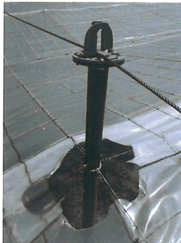
Figura 345. Cajetín de acero ranurado introducido en el pilar por los huecos de la tapaperforada
