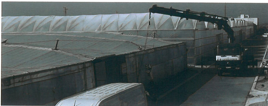
Figura 50. Dispositivo de anclaje con masa de prueba tras el ensayo 1
