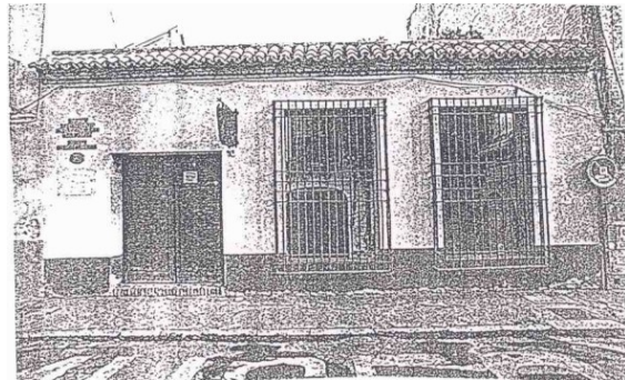
Fotografía del catálogo de PEPRI. Fachada Pasillo de Santa Isabel
