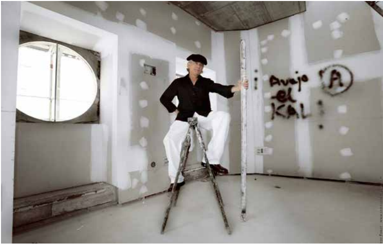
El escritor Juan Campos Reina, fotografiado durante las obras de rehabilitación para el catálogo 'La obra en marcha'. / PEPE PONCE.
