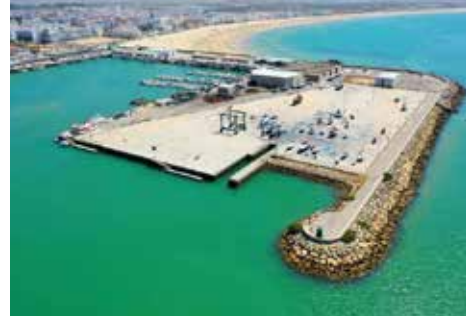
Área técnica exterior (2020)
