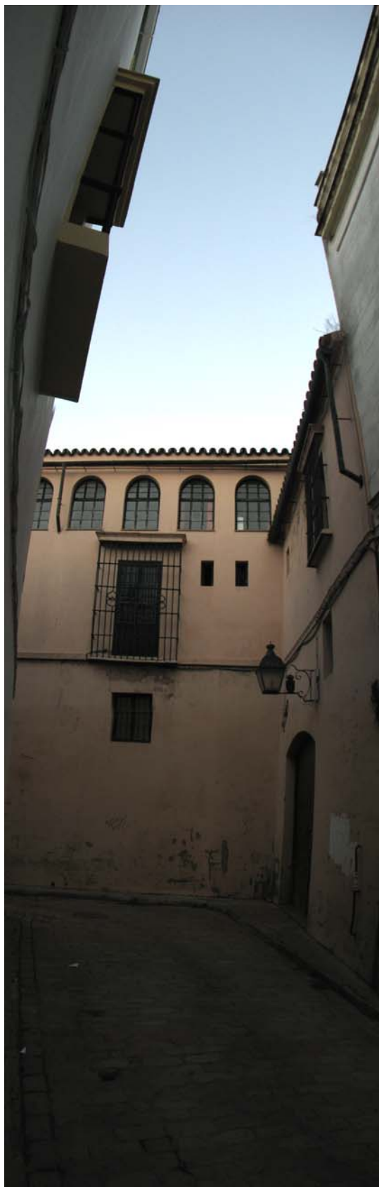
PE06_ Calle San Juan.
