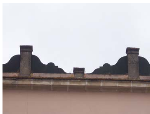
EX08_ Detalle de los remates de la cornisa.
