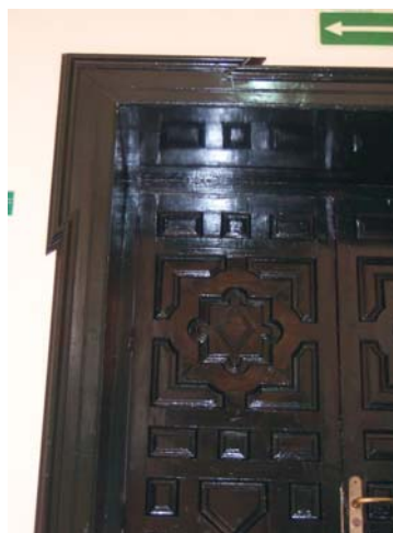
CA.08_Entreplanta. Acceso a salón de actos. Detalle.
