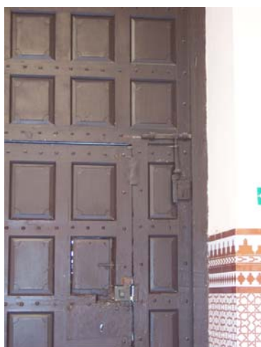
CA.02_Acceso al patio. Detalle.
