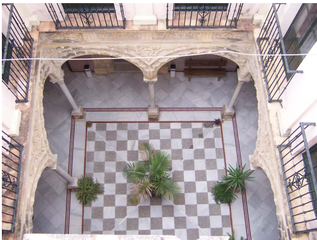
PA02, PA03_ Vistas de las arquerías desde la cubierta.
