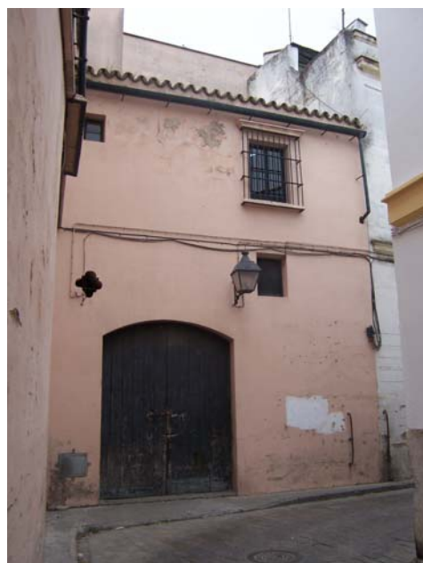
EX04_ Fachada a calle San Juan
