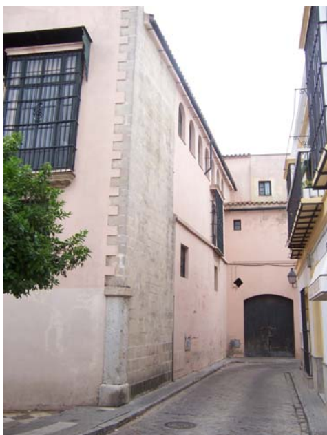
EX03_ Fachada a calle San Juan.
