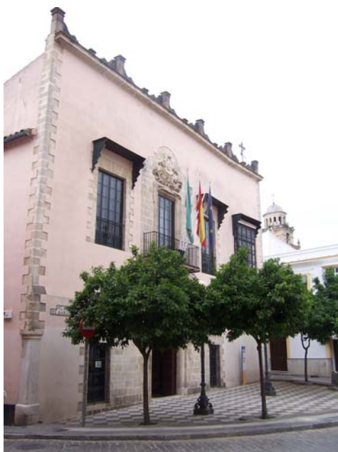
EX01_ Fachada a plaza San Juan.
