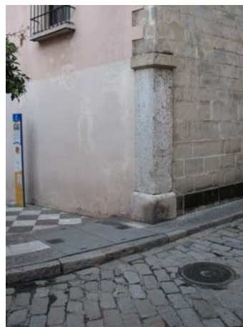
EX06_ Guardacantón calle San Juan.
