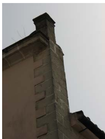
EX09_ Fragmento de fachada exenta.
