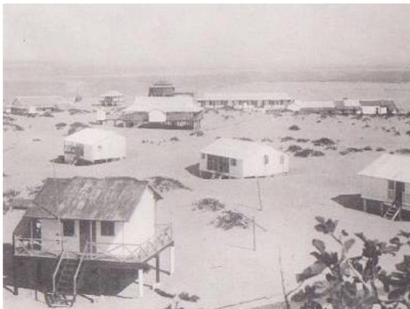
Edificios de la Río Tinto Limited Company
