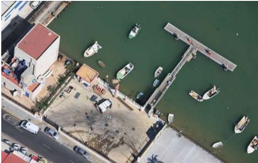
Pantalán de suministro de combustible y fábrica de hielo (2010)
