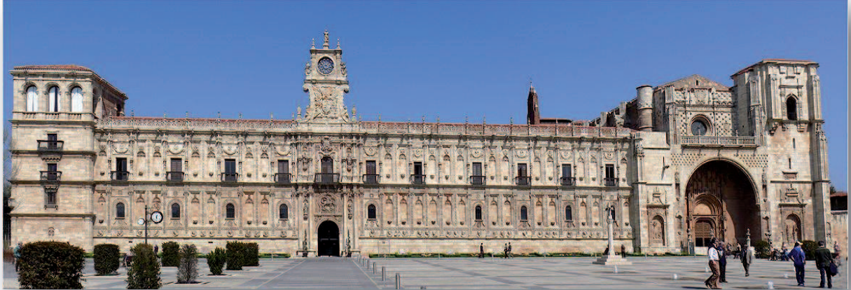
Figura 1.5a. Vista frontal del Convento San Marcos de León
