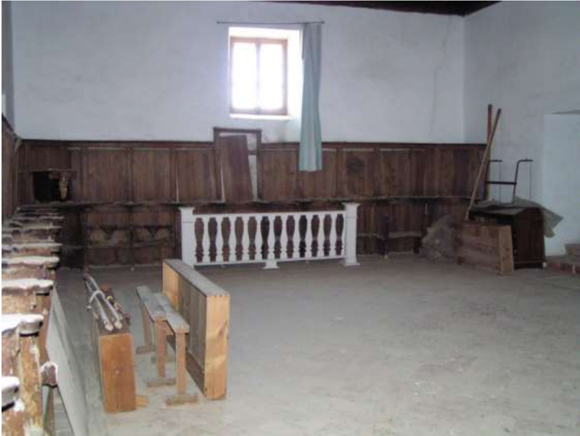
Fig. 3. Sillería del coro alto del convento de la Concepción de Carmona, proceso de deterioro muy avanzado por el abandono paulatino. (AMP).
