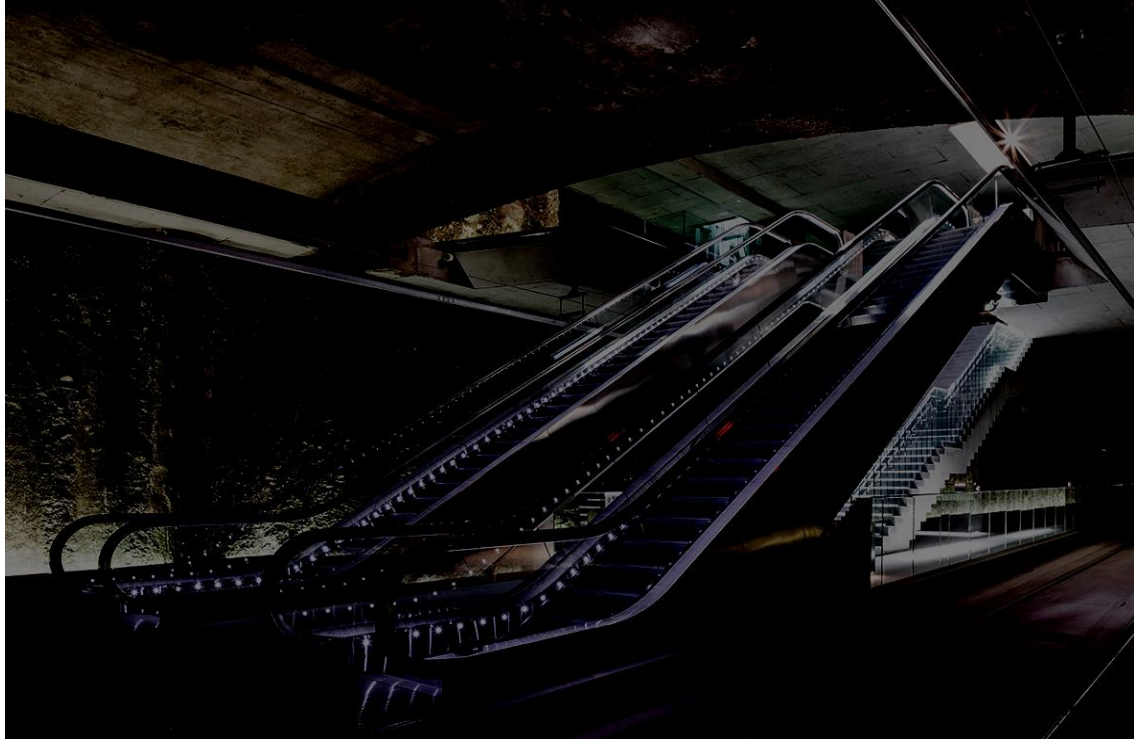
Imagen 3: Estación subterránea del Metropolitano de Granada. Fuente: Ayuntamiento de Granada.
