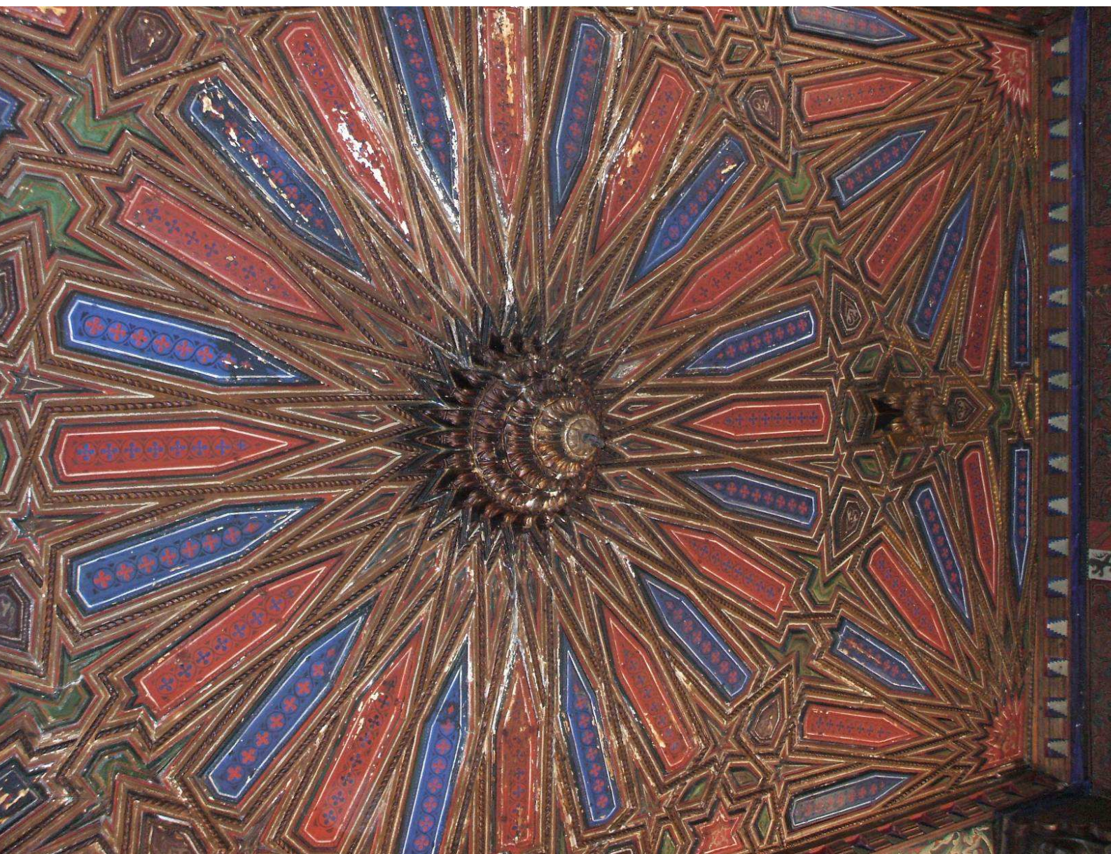
Alfarje del salón mudéjar. Palacio del Condestable Iranzo. Fuente propia.
