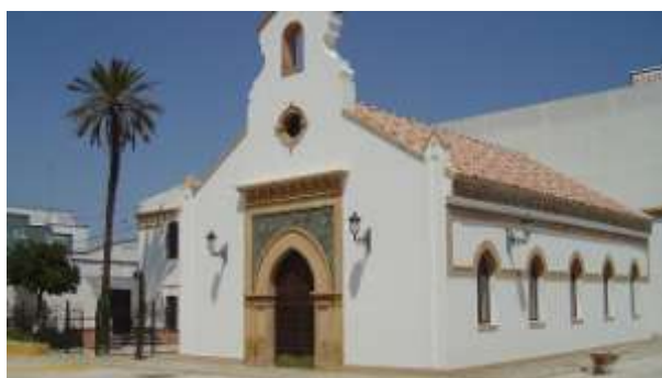
Figura 24. Capilla de las Escuelas del Ave María Fuente: Ayuntamiento de Dos Hermanas
