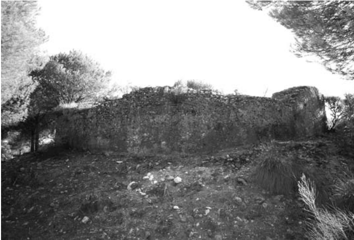
Restos de la Torre Vigía francesa denominada El Fuerte (Foto Luis Javier Guerrero)
